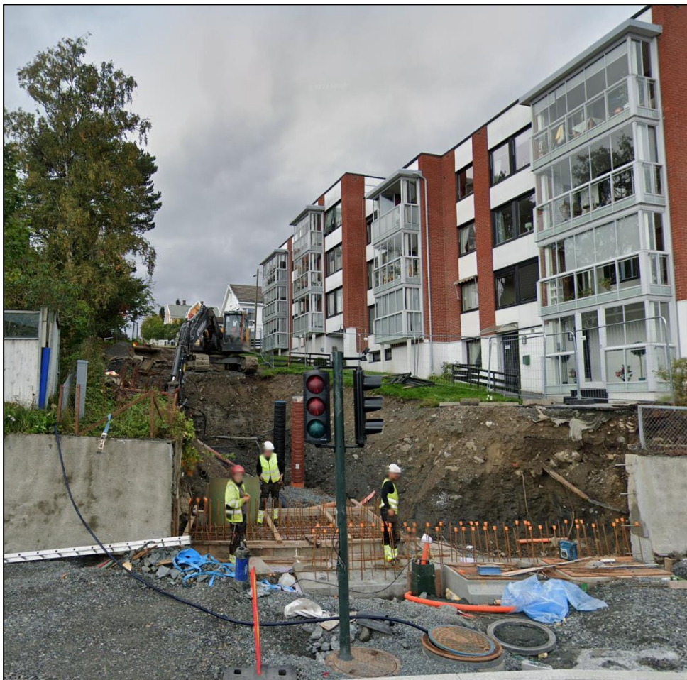
Figur 3-1: Bilde fra anleggsgjennomføring i prosjektets etappe 1
